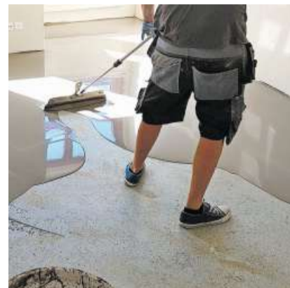
Handwerker bei der Arbeit.
