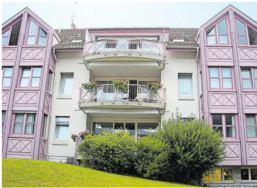
Das äussere Erscheinungsbild wurde weitgehend erhalten.
